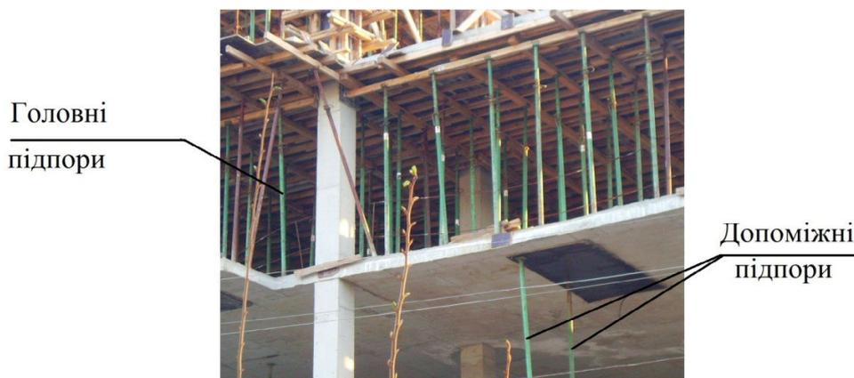
**Рис. 5. Допоміжні підпори, що запобігають деформаціям перекриття**
