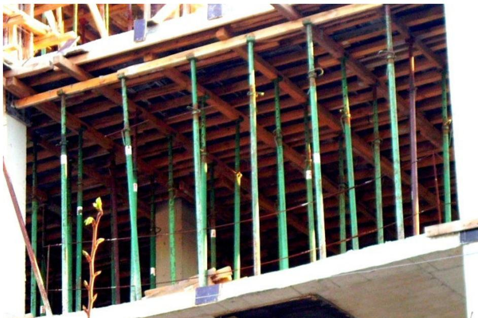
**Рис. 3. Улаштування дерев'яної опалубки**
