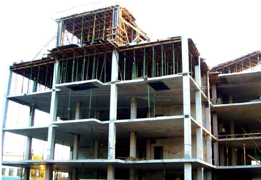
**Рис. 1.** Улаштування каркасно-монолітного перекриття
