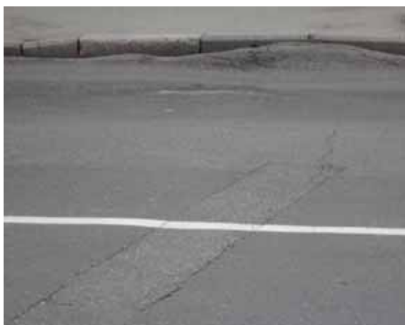
Рисунок 3 – Деформації та руйнування дорожнього одягу по вул. Леніна (зупинка «Млинкомбінат»)
