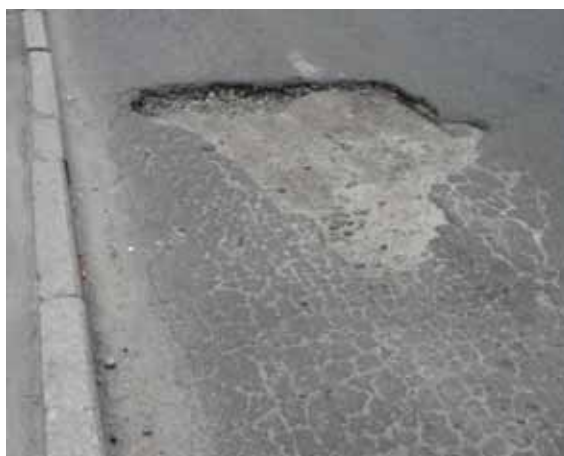
Рисунок 3 – Деформації та руйнування дорожнього одягу по вул. Леніна (зупинка «Млинкомбінат»)
