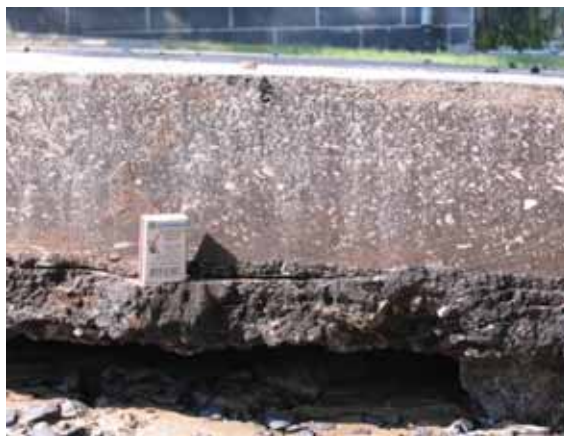
Рисунок 2 – Конструкція дорожнього одягу по вул. Леніна (перехрестя з вул. Пролетарська)
