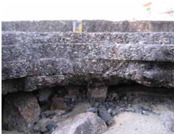
Рисунок 2 – Конструкція дорожнього одягу по вул. Леніна (перехрестя з вул. Пролетарська)
