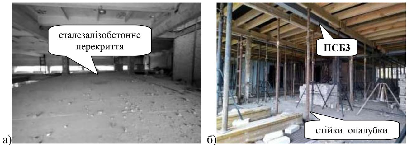
Рис. 4.29 – Загальний вигляд на сталезалізобетонне перекриття:
