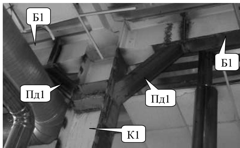
Рис. 7.6 – Загальний вигляд влаштованих підкосів підсилення
