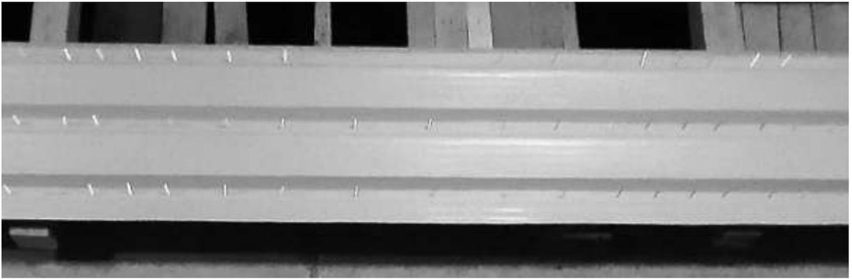
Рис. 5.27 – Вигляд встановлених анкерів у профнастил перед бетонуванням
