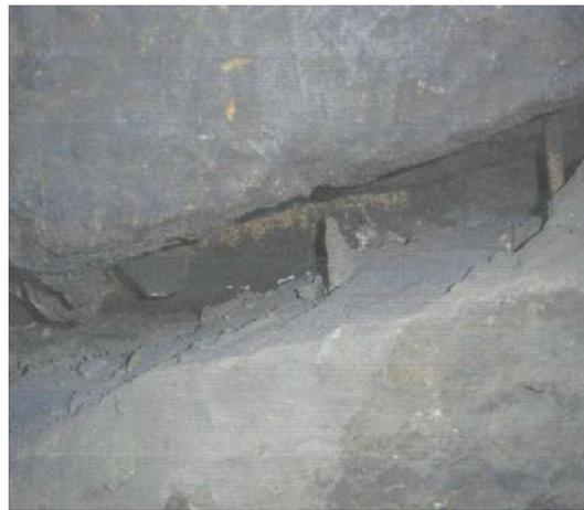
**Рис. 4. Горизонтальна арматура та кородування арматури в стіні фундаменту Ф-3**
