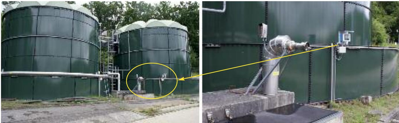
Рис. 5.13.3. Система спостережень за станом накопичення біогазу
