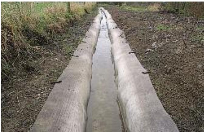
**Нагірна канава, укріплена бетонним полотном**
