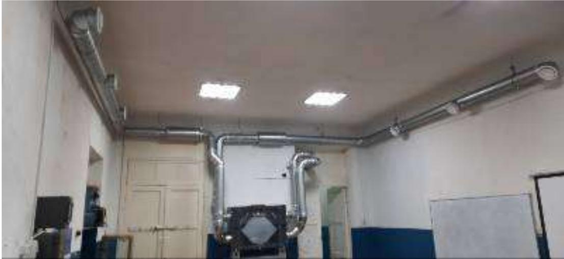
**Рисунок 1 – Утилізатор (рекуператор) теплоти вентиляційного повітря**
