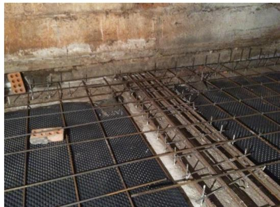
**Рисунок 2 – Улаштування монолітних залізобетонних балок та плити посилення**
