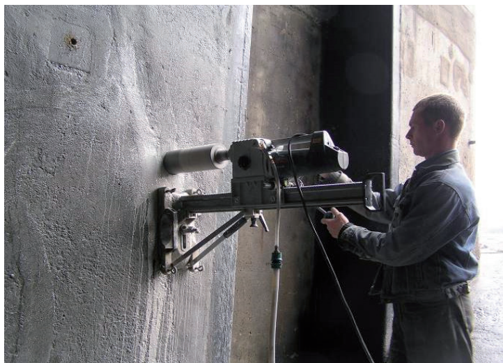
Рис. 4. Вибурювання кернів зі стінки роздільного бичка.
