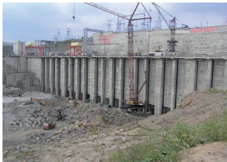
Рис. 3. Загальний вигляд з нижнього б'єфу на будівлю Ташлицької ГАЕС на р. Південний Буг.
