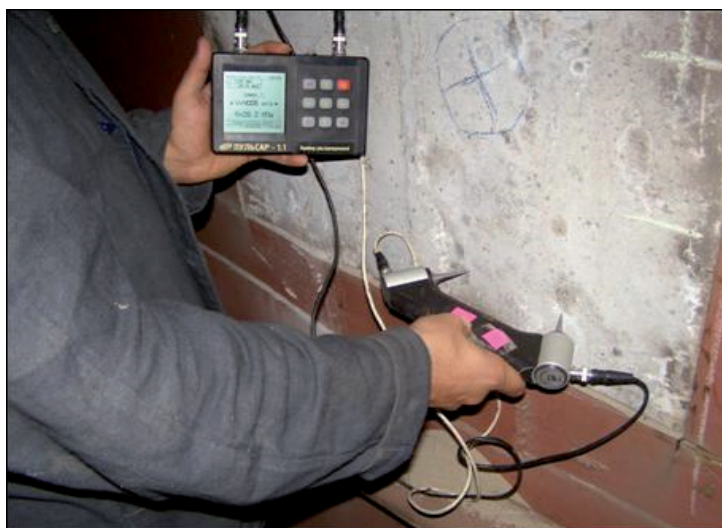
Рис. 6. визначення міцності бетону ультразвуковим методом приладом «ПУЛЬСАР 1.1».
