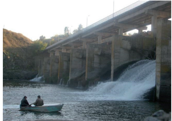
Рис. 8. Загальний вигляд водозливної греблі зі сторони нижнього б'єфу Гайворонська ГЕС на р. Південний Буг.
