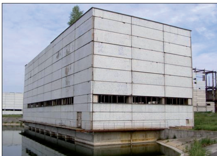
Рис. 5. Загальний вигляд будівлі БНС-3 Хмельницької АЕС.
