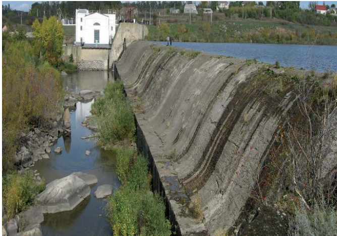
Рис. 7. Загальний вигляд водозливної греблі зі сторони лівого берега Краснохуторської ГЕС на р. Синюха/
