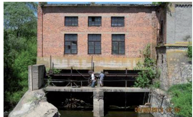
Рис. 10. Загальний вигляд водозливної греблі з верхнього б'єфу гідровузла на р. Случ.
