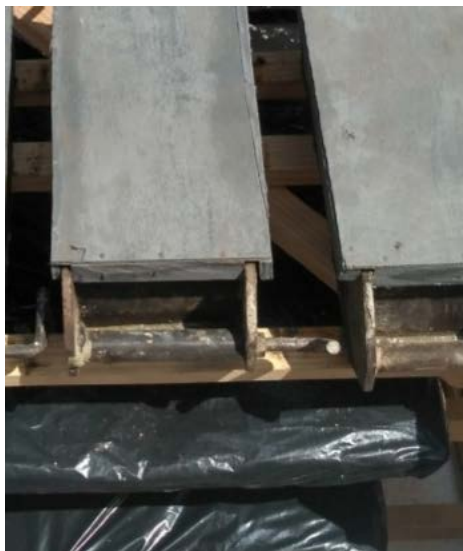
Рис. 2. Гідроізоляція плит і кубів
