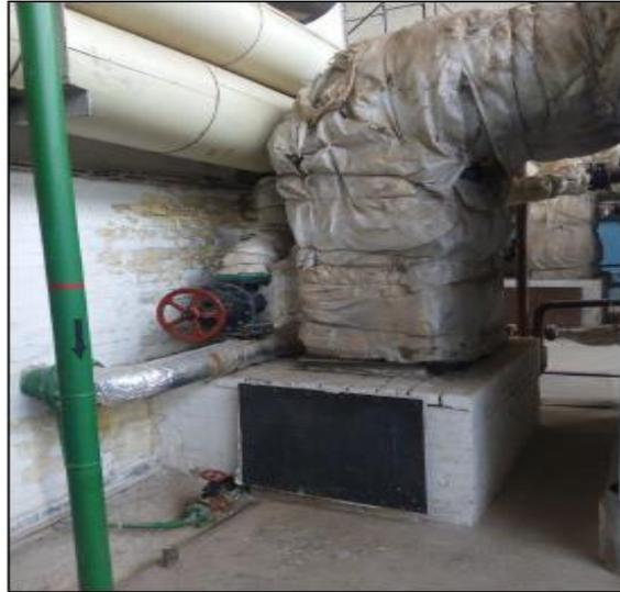
**Рис. 3. Встановлення утилізатора теплоти відхідних продуктів згорання після котла ТВГ-8**
