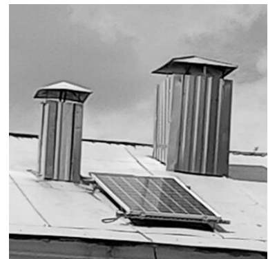
Рис.2. Розташування фотоелектричної панелі на даху лабораторії кафедри ТГВ та Т
