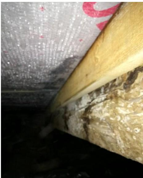
Вентиляція перешкоджає утворенню на поверхні покрівлі льоду та бурульок, не дає намокнути утеплювачу через утворений конденсат (рис.3), тобто допомагає уникнути тепловтрат та втрат несучої здатності. Особливо важлива стабільна циркуляція повітря пізньою осінню та ранньою весною.
