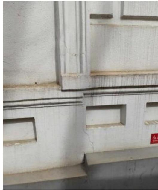
Рис.1.Дефекти об'єкта: а) відшарування штукатурки і подальше руйнування карнизу; б) деформація стін внаслідок нерівномірного осідання;
