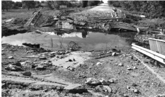
Рисунок 1 – Ступені пошкодження та руйнування автомобільних доріг:
