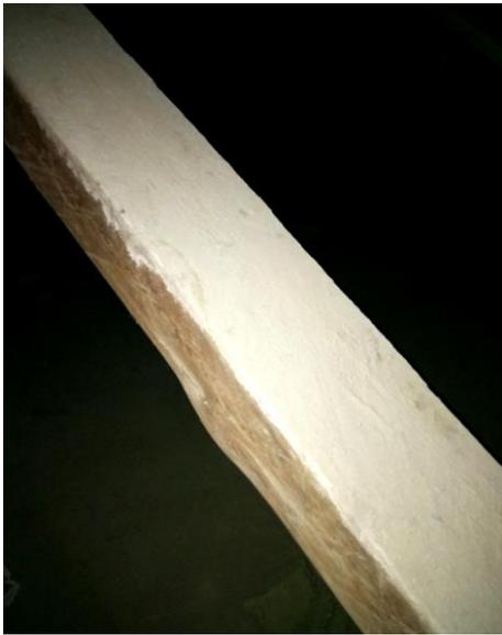
Рис.1. Біла пліснява на кроквах та укосах
