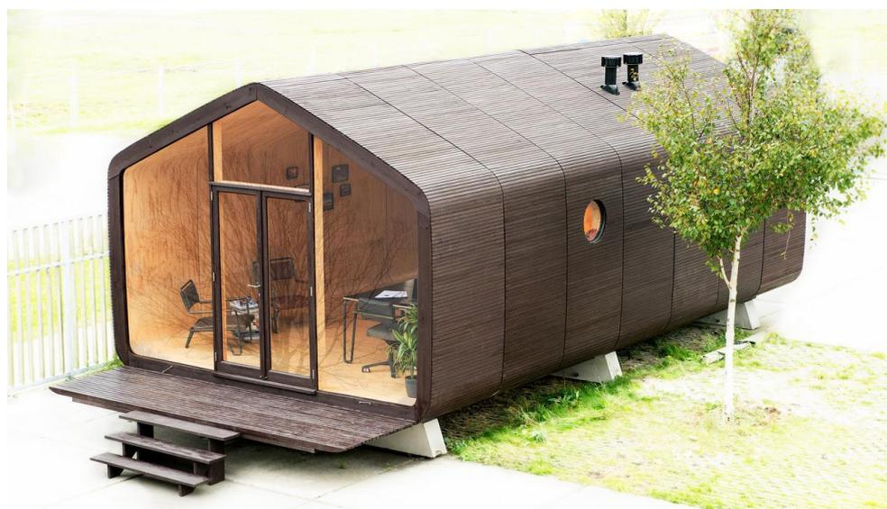
Стійкий інноваційний модульний будинок, виготовлений з повторюваних картонних модулів, загорнутих у міцні трубки і покритих спеціальним скловолокном. Модульне житло, яке складається з сегментів розміром 4,6 м завдовжки х 1,2 м завширшки х 3,5 м заввишки, можна розширювати та доповнювати за потреби.
