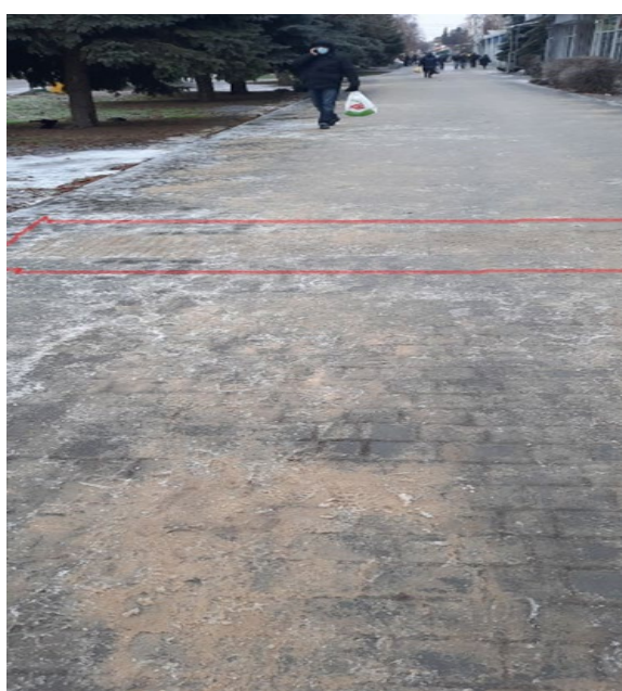
Рис. 1.10. Безсистемне дезорієнтуюче розташування тактильних смуг, невірне укладення тактильної плитки на проїзній частині, м. Полтава
