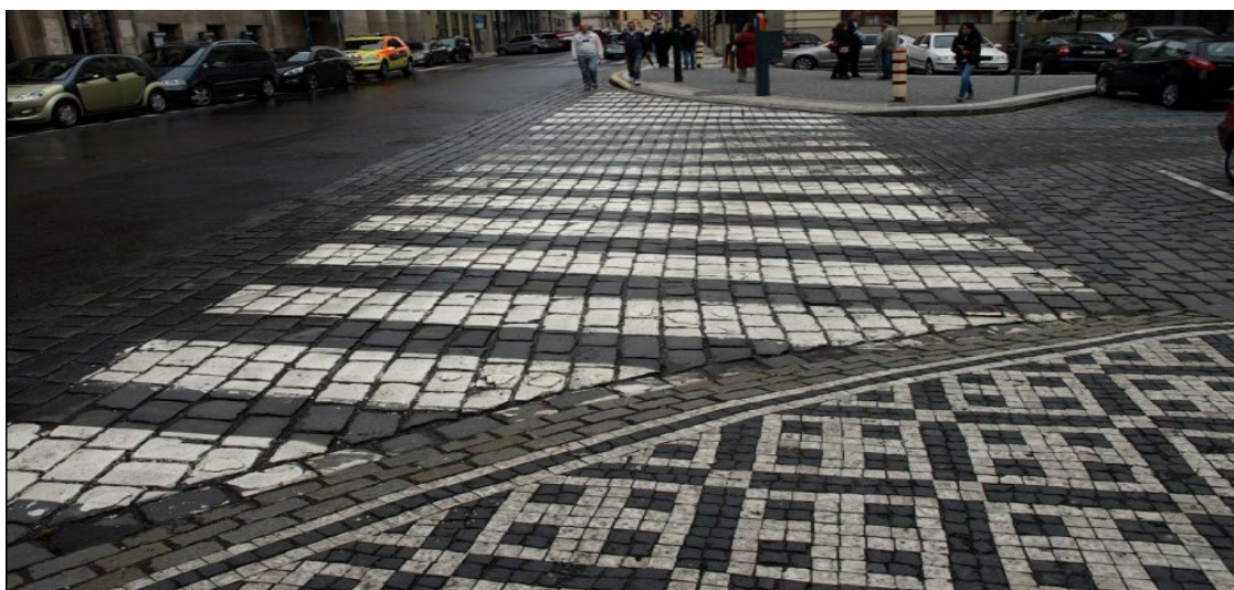
Рис. 1.22. Приклад забезпечення зручності пішохідного переходу для МГН
