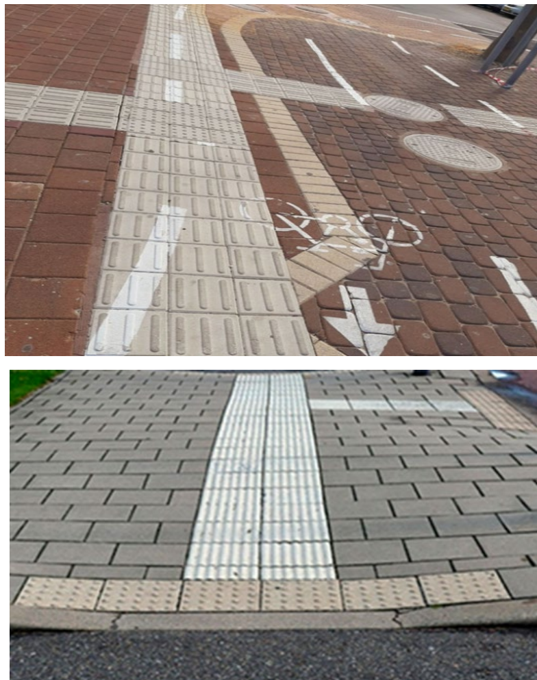
Рис. 1.15. Приклад застосування тактильних смуг (Ізраїль)
