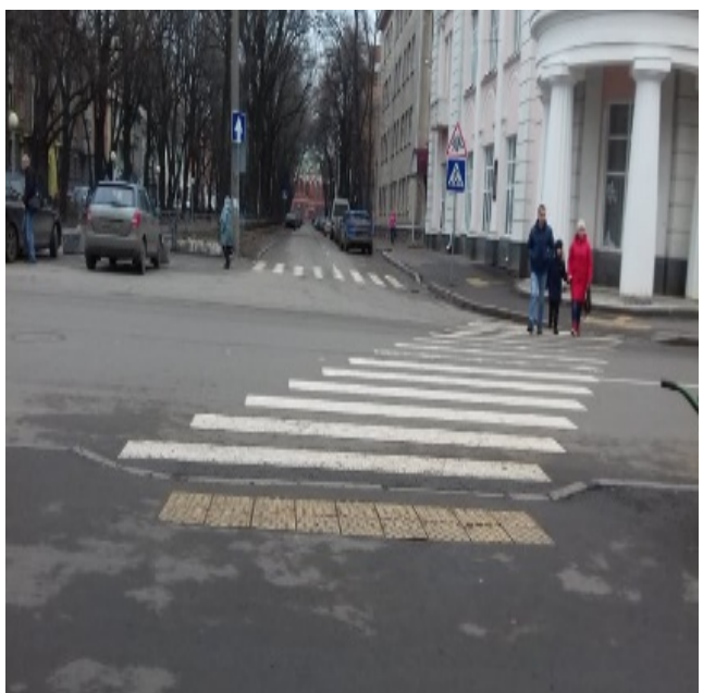
Рис. 1.10. Безсистемне дезорієнтуюче розташування тактильних смуг, невірне укладення тактильної плитки на проїзній частині, м. Полтава
