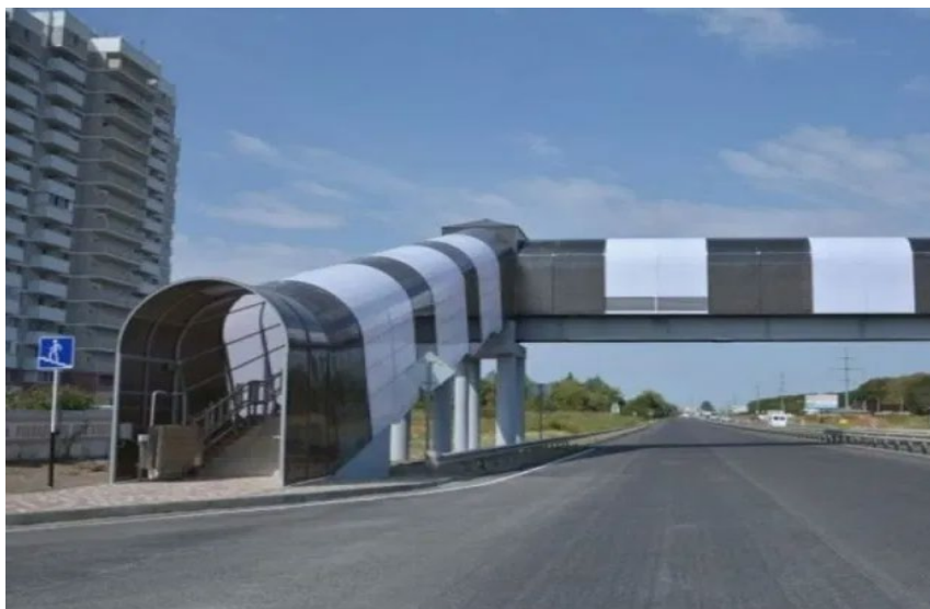
Рис. 3.12. Надземний пішохідний перехід що слугує для розділення пішохідних та транспортних потоків який обладнаний під потреби маломобільних груп населення та слугує для безпечного перетину дорожньої мережі де є недоцільним встановлення наземних пішохідних переходів
