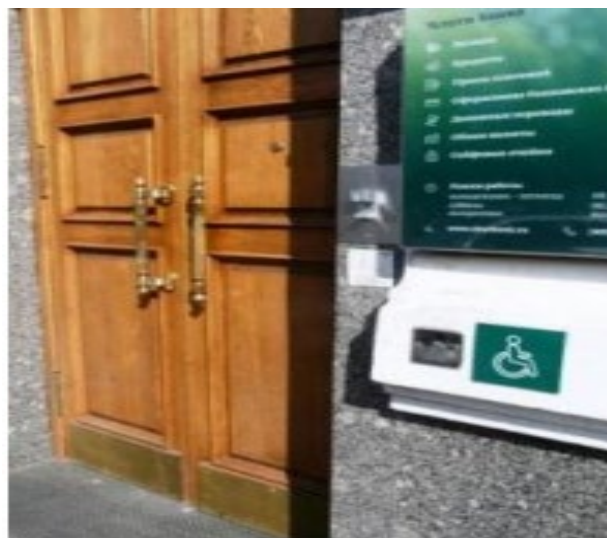
Рис. 3.5 Кнопка автоматичного відкриття дверей зі швидкість реакції на сигнал не більше 15 секунд для людей, які пересуваються за допомогою інвалідного візку
