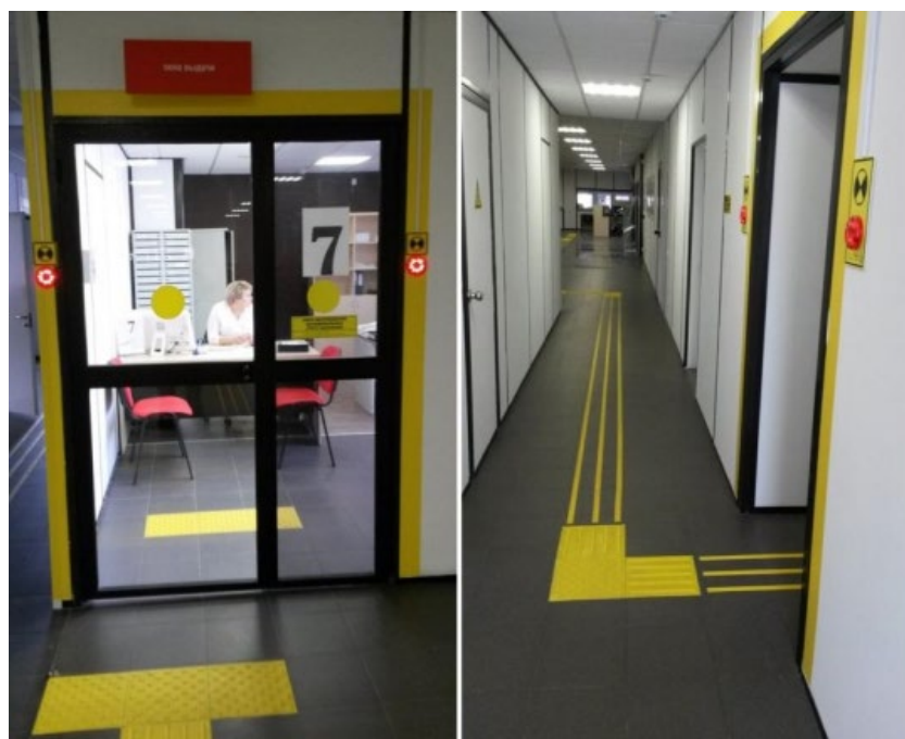
Рис. 3.7 Приклад послідовного розташування різних напрямних елементів до певного об'єкту
