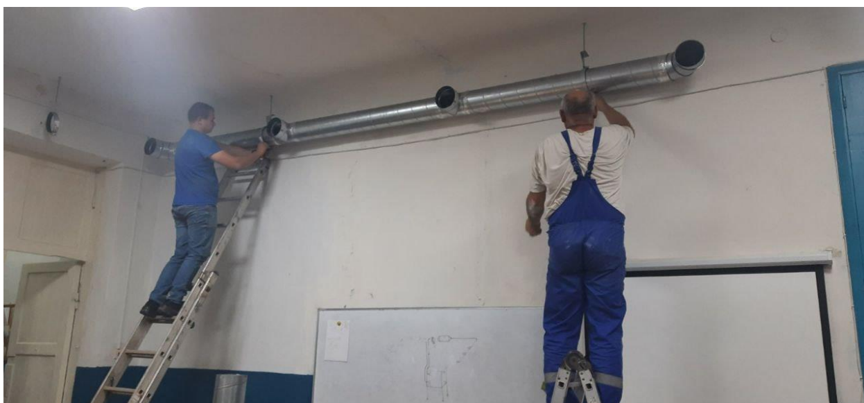
Рис. 4.15-4.16. Монтаж повітропроводів у готові кріплення.
