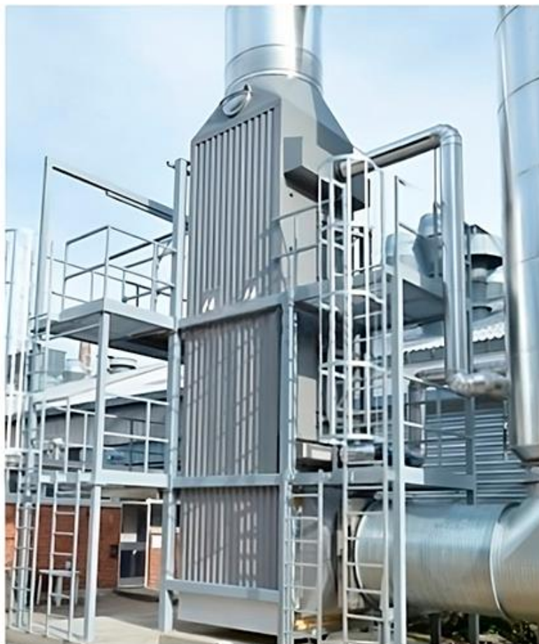
Рис. 2.1. Промисловий утилізатор теплоти димових газів.
