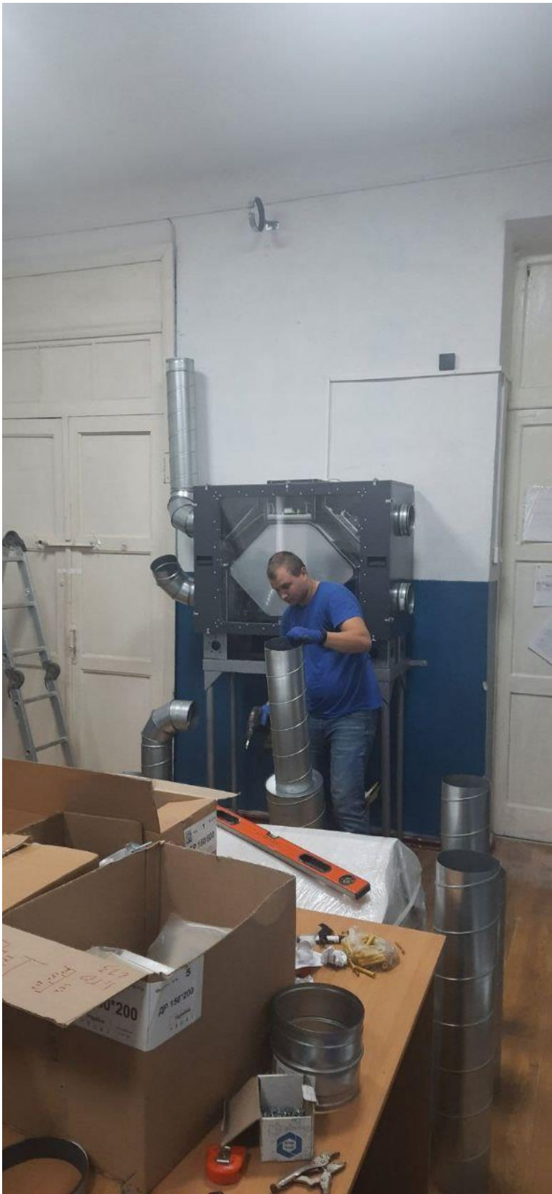
Рис. 4.14. Приєднання елементів вентиляції до рекуператора.
