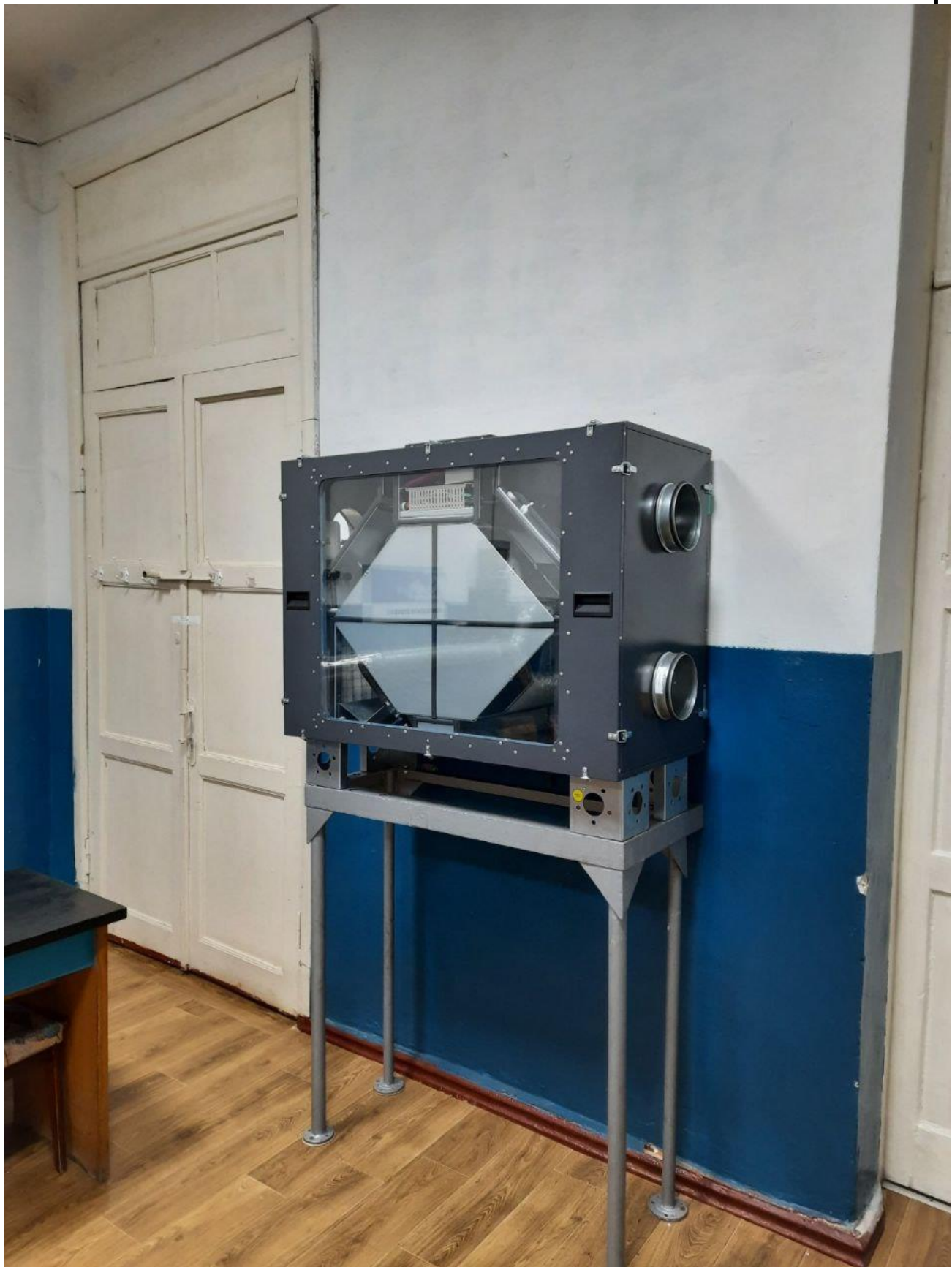
Рис. 4.6. Змонтований утилізатор «AeroStar» до стійки.
