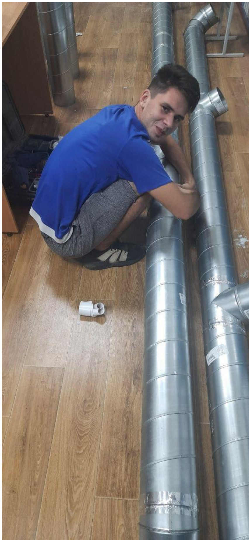
Рис. 4.12-4.13. З'єднання елементів повітропроводів.
