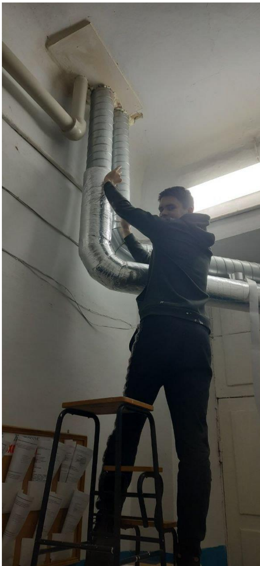
Рис. 4.21-4.22. Утеплення припливного повітропроводу.
