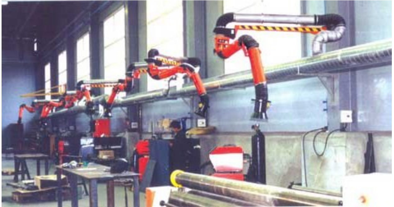
Вентиляція у механічному цеху
