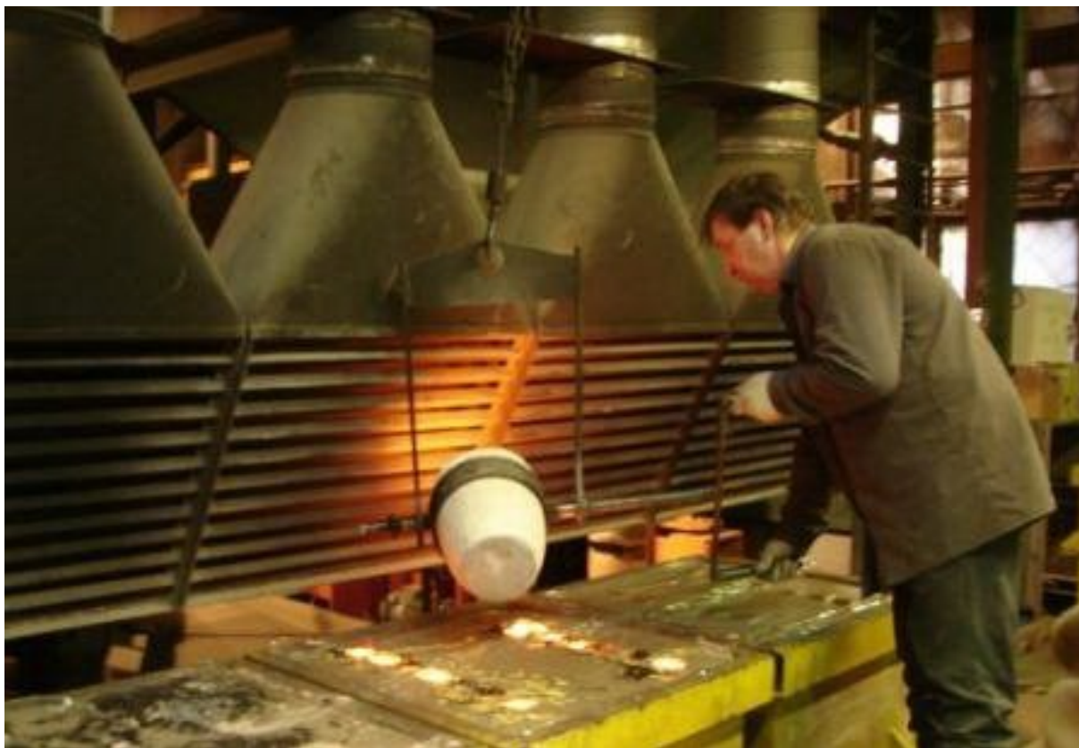
Вентиляція ливарного цеху
