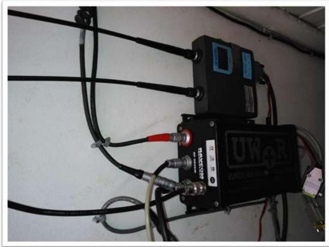
Рисунок23 : Кріплення приймача та радіо модем
