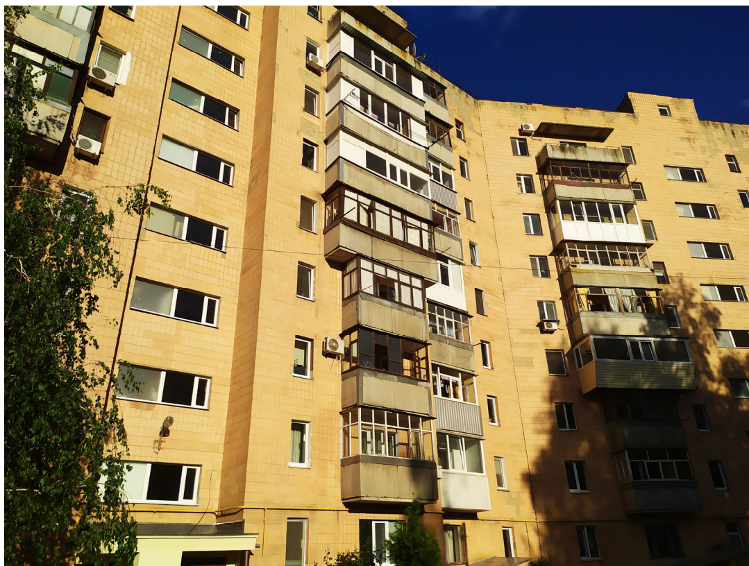
Рис. 2.3 – Загальний вигляд будівлі по осям А і 3
