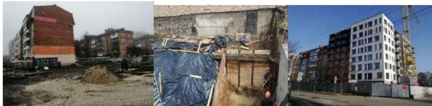
**Рис. 2.** Майданчик до відкопування котловану (а), монтаж підкосу між обв'язувальною балкою та новим ростверком (б), сучасний вигляд майданчику (в).
