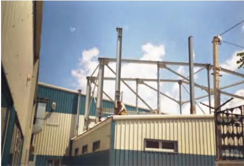
*Рис.3. Монтаж конструкцій надбудови*
