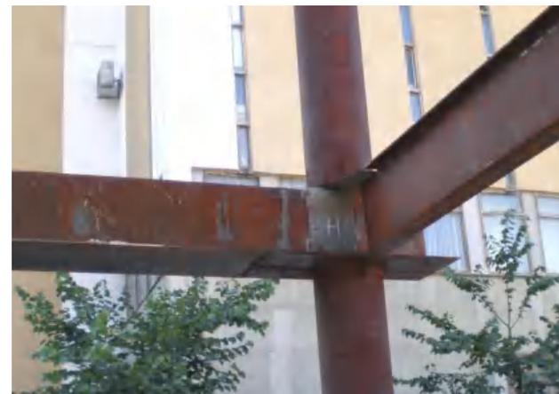
*Рис.1. Вузол сполучення трубобетонної колони та сталобетонного ригеля.*
