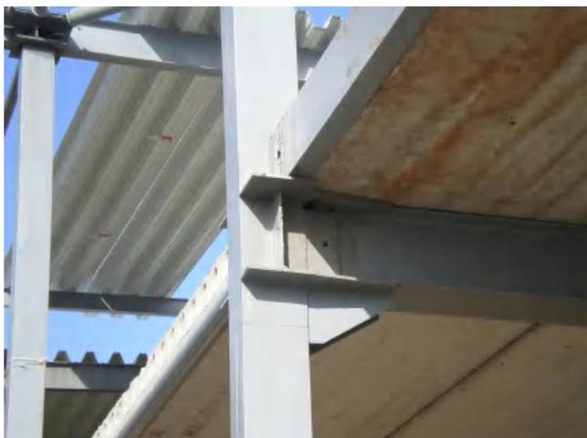
Рис.2. Трубобетонна колона із 2-х швелерів
