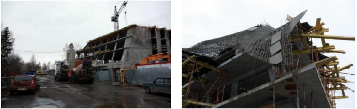
Рис. 2.4. Обвалення конструкцій офісного центру під час будівництва, Архангельськ
