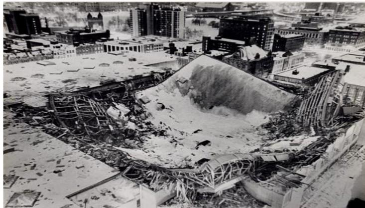
Рис. 2.10. Обвал перекриття спортивної арени в місті Хартфорд (США), 1978 рік
